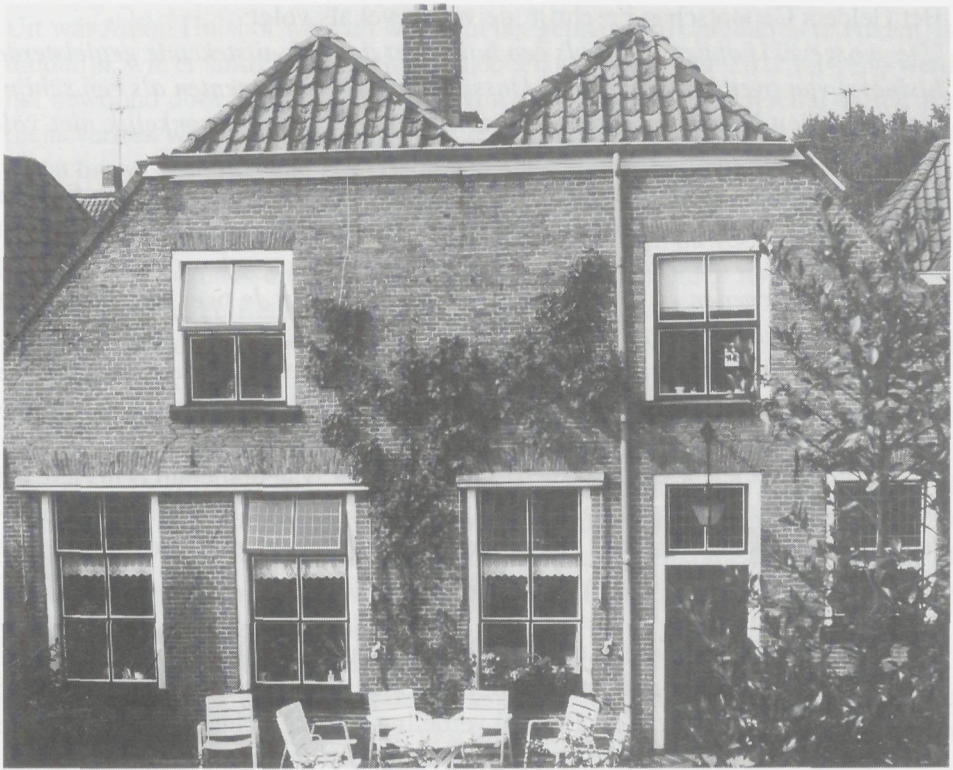
Achtergevel. Vroeger de voorgevel met uitzicht op de Hagen. Foto: A. Hulshof
