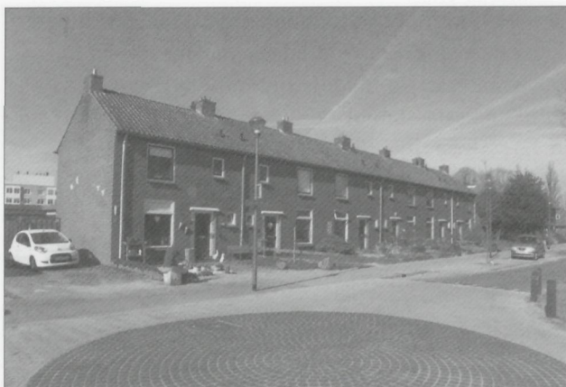
De oude woningen aan de vernieuwde Huenderstraat.
