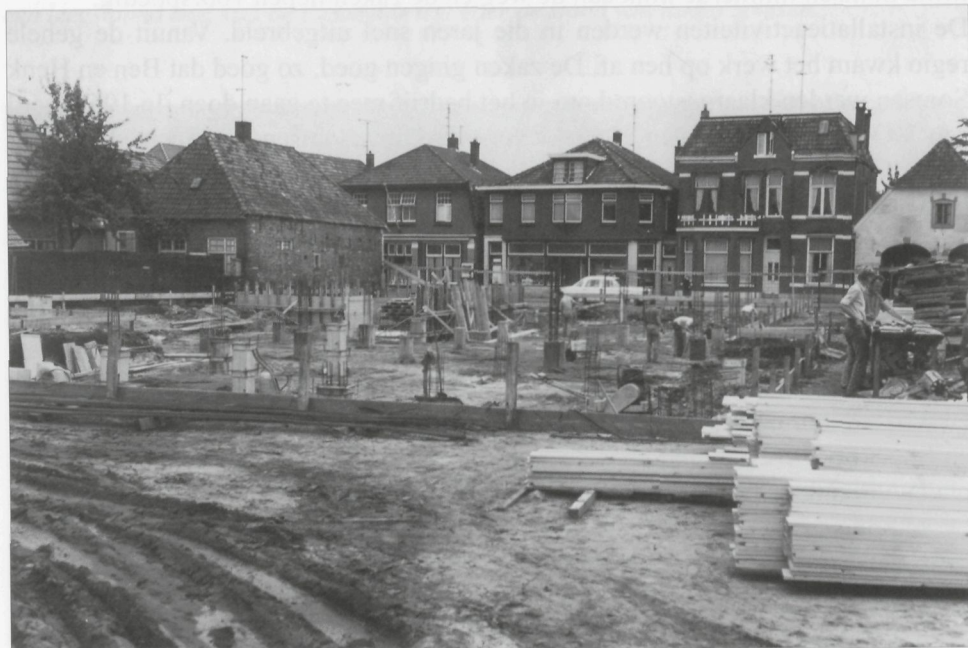
De vorm van het nieuwe pand wordt al zichtbaar.
