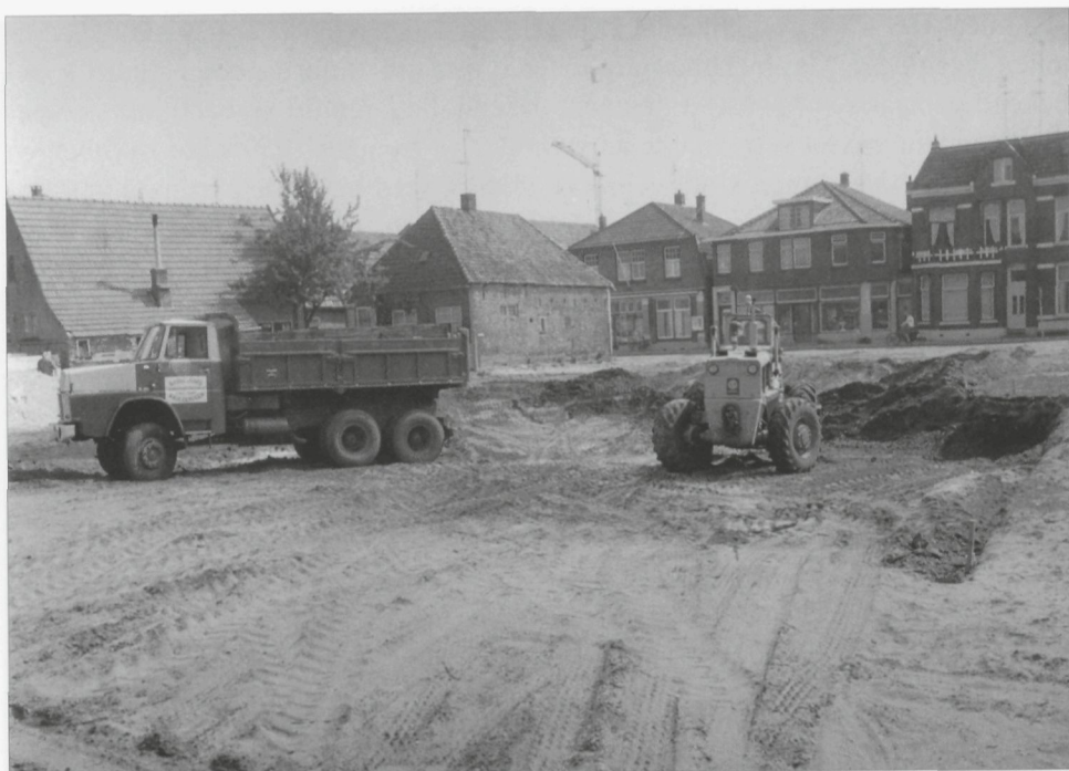
1970. Grondwerkzaamheden voor het nieuwe winkelpand op de hoek van de Nieuwstraat / J.W. Hagemanstraat
