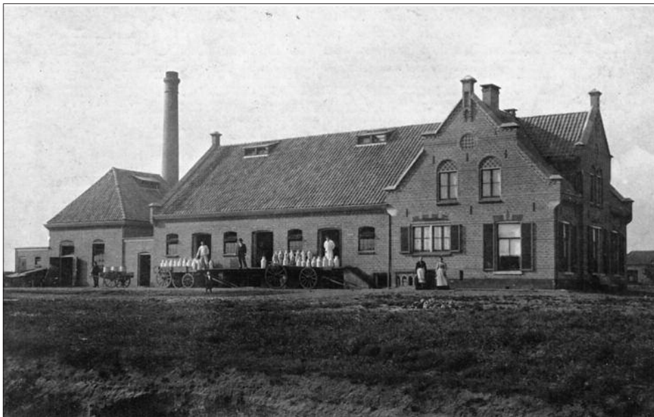
De Eibergse Zuivelfabriek aan de Hupselseweg (collectie: museum De Scheper).
